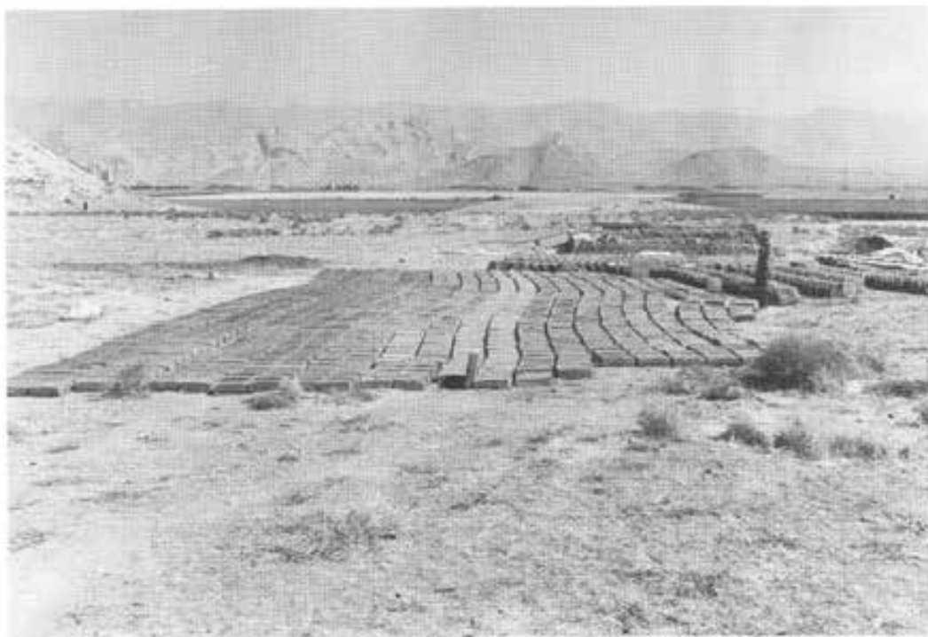
تصویر ۴۶۴. تپه ازبکی، خشتهای تولید شده برای مرمت و بازسازی دژ ازبکی.
