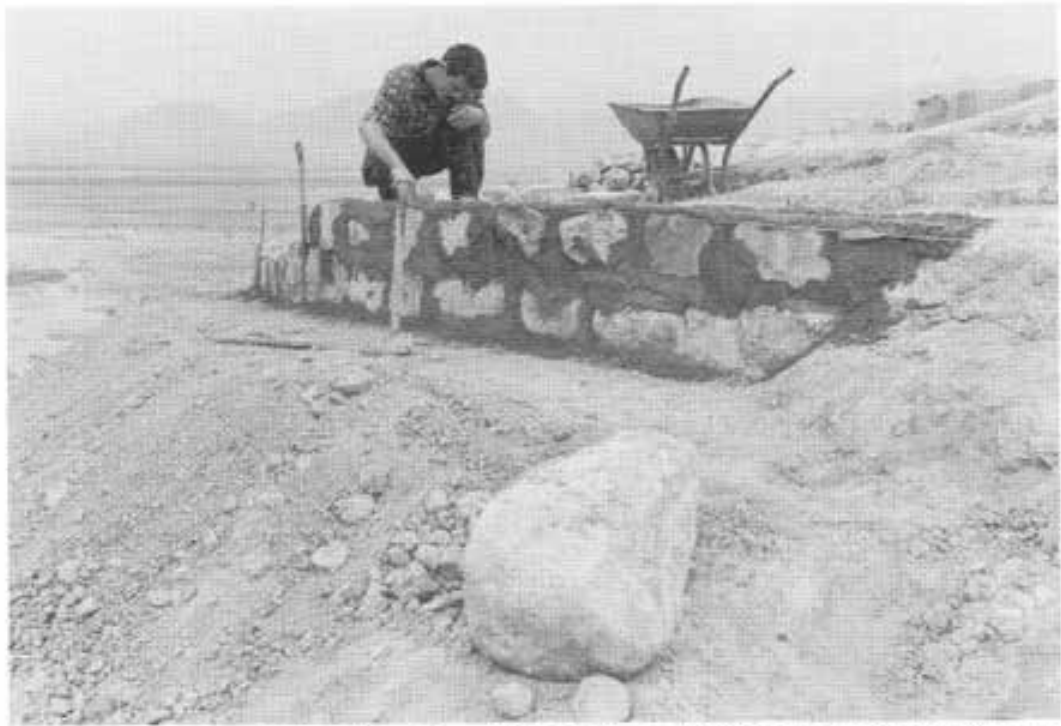
تصویر ۳۸۰. محوطه ازبکی، دژ مادی، کارگری در حال بازسازی قسمت‌های ریخته پی سنگی دیوار دژ.
