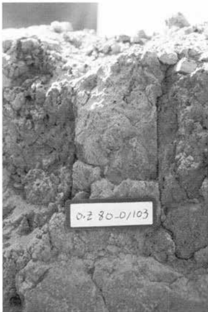
تصویر ۴۹۳. ملات‌های خاکستری بکار رفته در دیوارهای دژ ازبکی.
